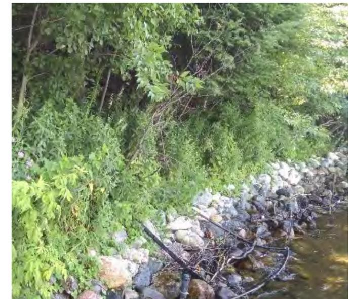
**ROCK RIPRAP TOE WITH UPLAND GEOTEXTILE BAGS**
